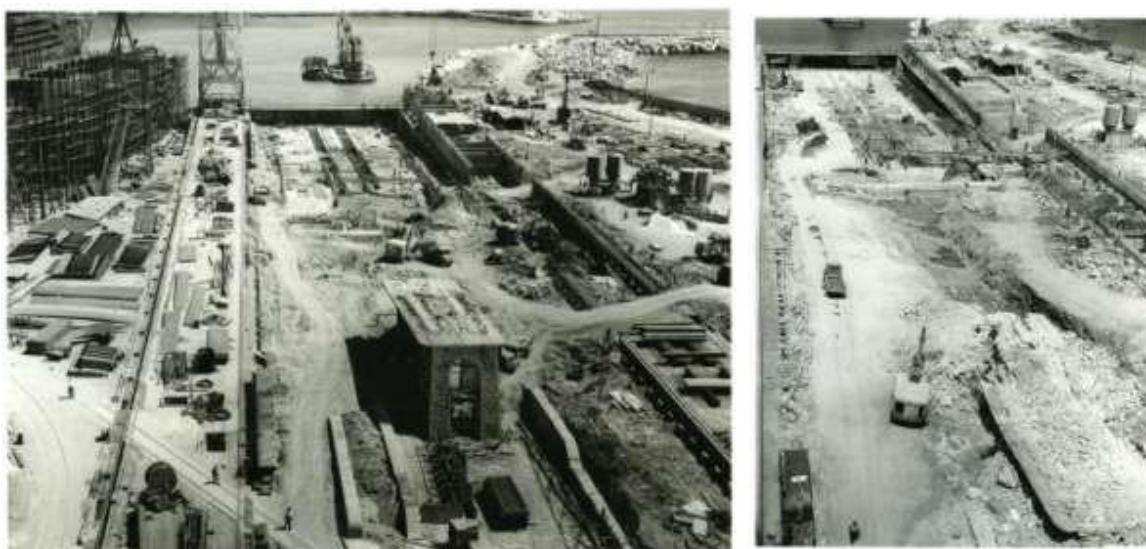
Figure 1 : Démolition et reconstruction de la partie basse de la cale 1, 1957.
