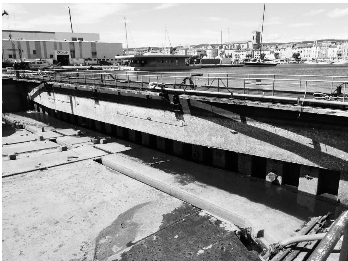
Figure 3 : Vue du bateau porte depuis la cale 1. L'étanchéité est quasi parfaite. ©Gaston Neulet, MCN.
